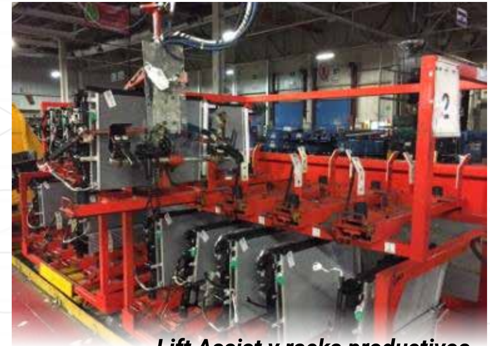
Lift Assist y racks productivos para manejo de radiadores
